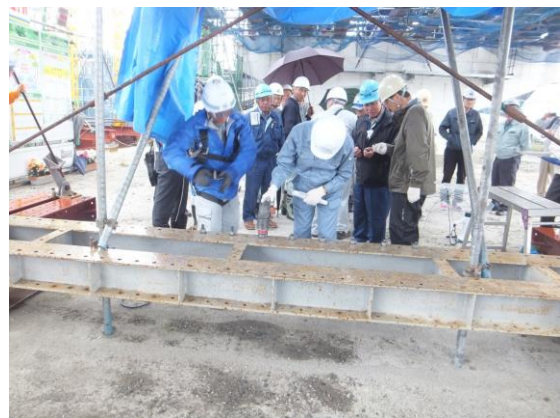
写真3 高張力ボルトの緊張体験
