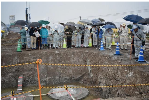
写真1 地盤改良現場の見学
