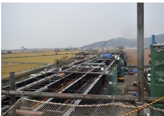
写真2 橋梁架設工事現場の見学
