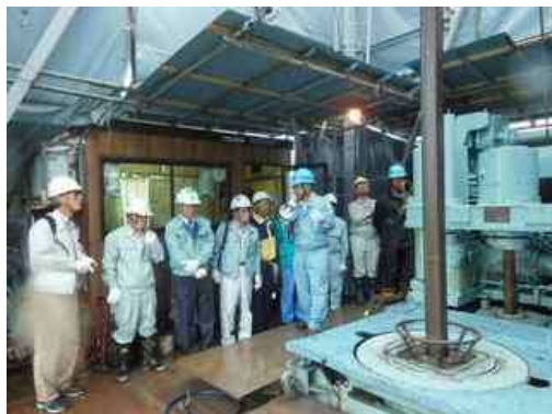
写真4：ボーリング掘削現場
