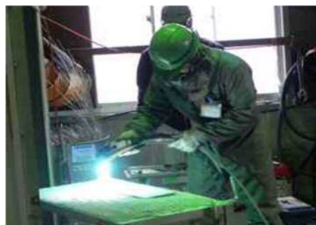
写真：溶射状況 2014.02.07
