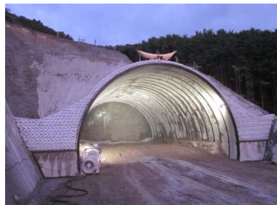
「安全祈願式前夜のトンネル坑口」
