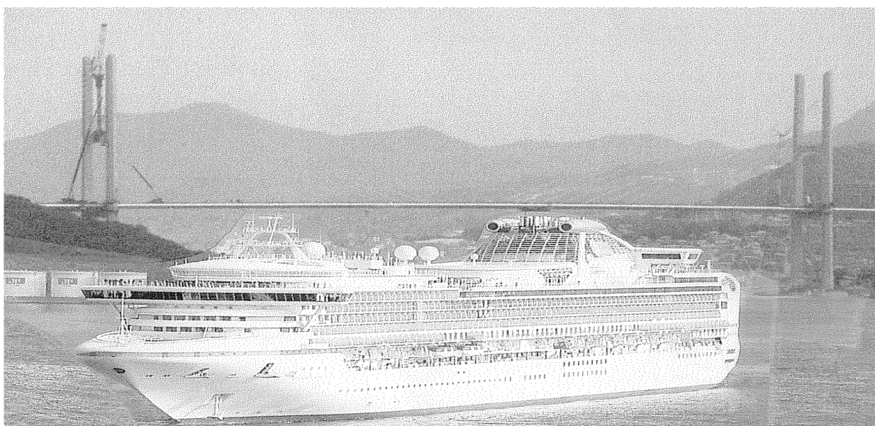
長崎港（建設中の女神大橋と豪華客船）
