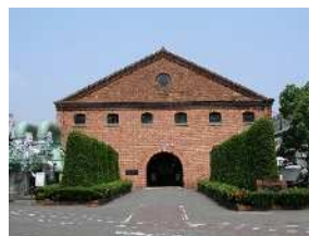
旧木型場 (現在) 建物工事のため、休館中 提供「三菱重工業(株)」
