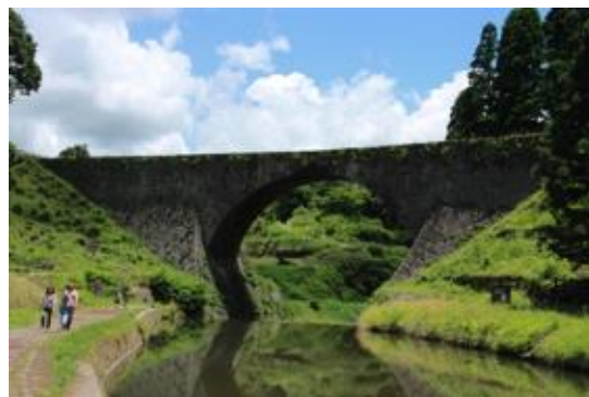
写真2 通潤橋（熊本県）
