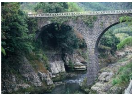
写真4 荒瀬橋(大分県)
