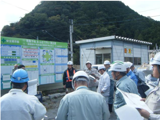
国道 251 号（飯盛）地すべり災害工事現場見学 （概要説明状況）
